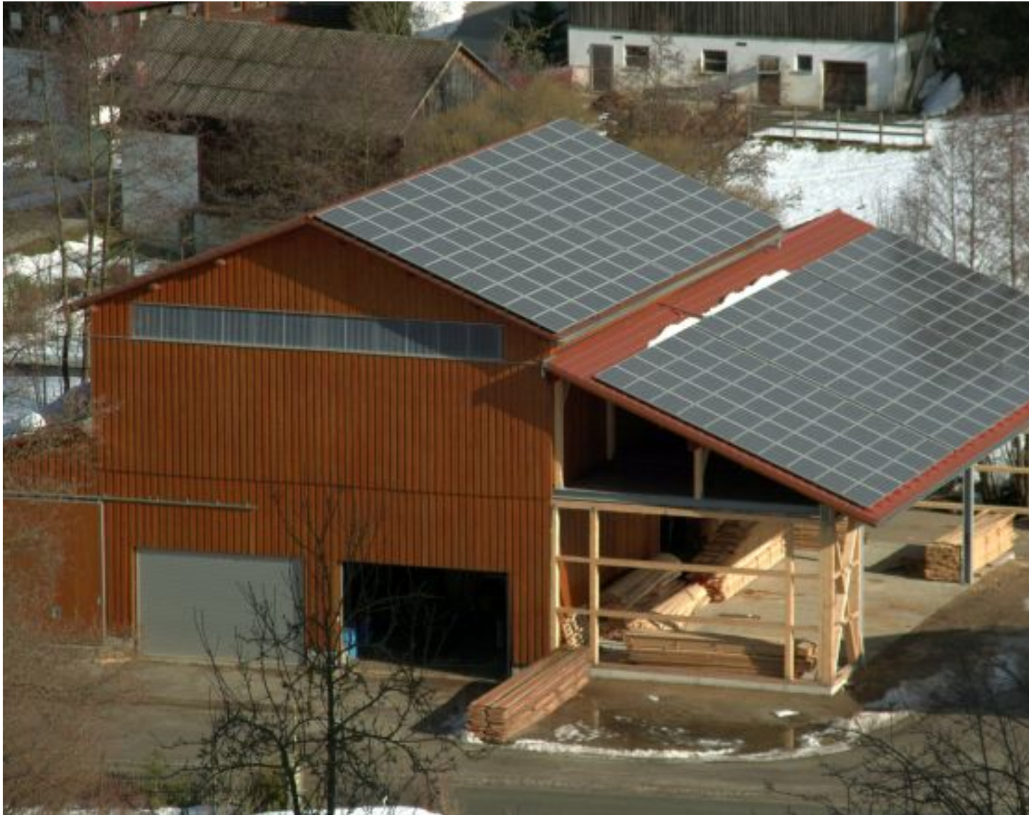
Photovoltaikanlage in Schweinsberg (Gemeinde Falkenstein)
